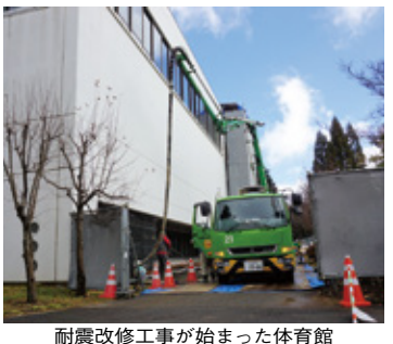
耐震改修工事が始まった体育館
