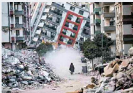
トルコ南東部カラマンマラシュで崩壊した建物
