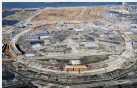
大阪関西万博（仮称）夢洲メイン会場建設中
